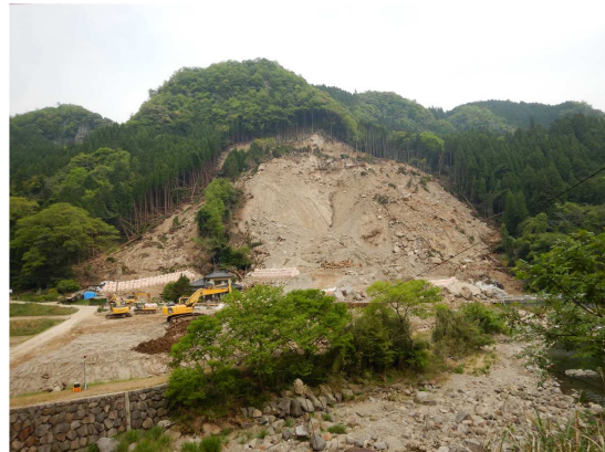
崩壊斜面の様子(平成30年4月30日撮影)
